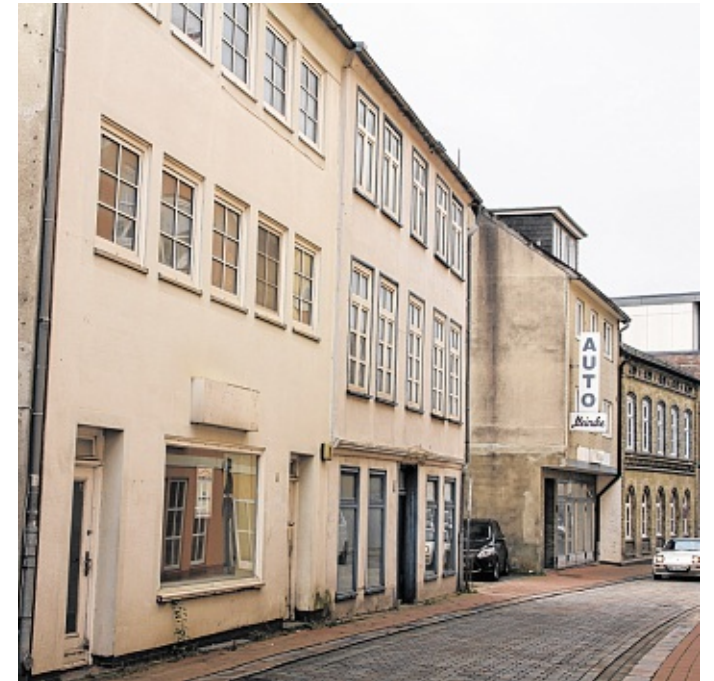
Die beiden Häuser links werden abgerissen.
